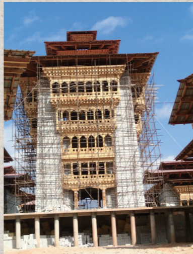
▲建設中の法学校。
