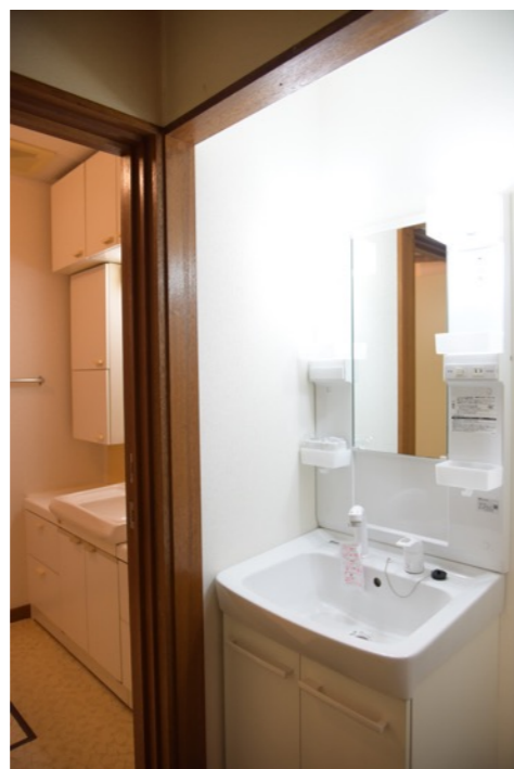
洗面台 ※ 2台設置
